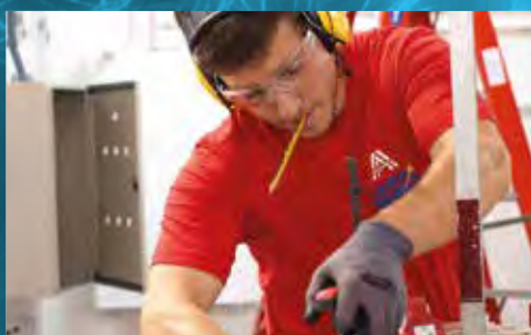
// Electrical Installations / Elektrotechnik
